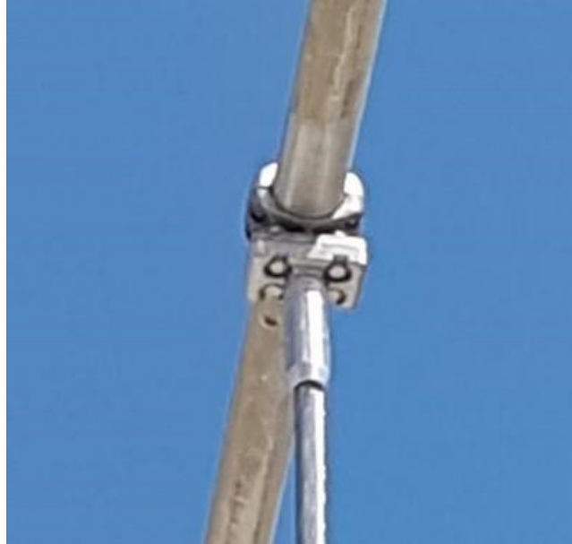
Figura 56 - Conexão de cabo \Phi 36mm ao tubo \Phi 100mm
